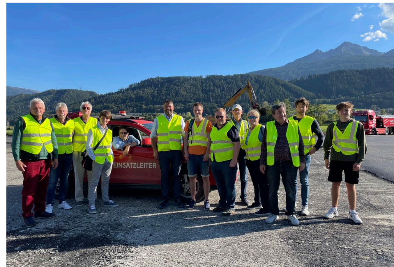
Flughafenfreunde bei der Besichtigung der Pistensanierung am Flughafen Innsbruck.
