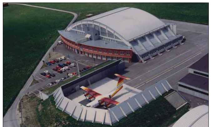
Fertigstellung der neuen Werftanlage mit dem Triebwerks-Probelaufstand (November 1992). Foto: Tyrolean Airways, Austrian Airlines, Wien
