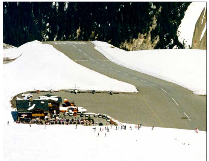
Die Piste weist eine Länge von 537 m und eine Breite von 40 m auf.
